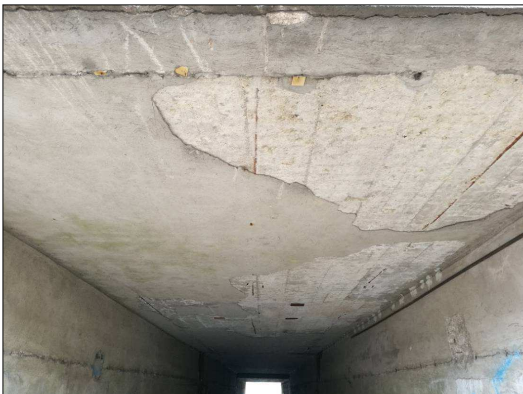
Obr. č. 5 - pohled na spodní líc NK s opady omítky a odhalenou výztuží - zleva
